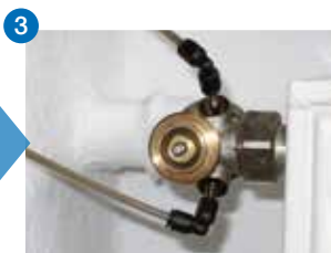
3. Messsonden einführen
